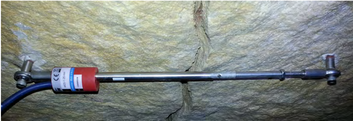
FIGURE 1 – Implantation d'un fissuromètre
